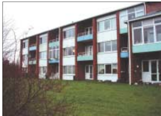
Havefacader, vinduesbrystninger efterisolerede og beklædt med plader
